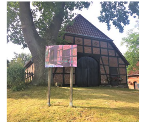
Abb. 28 Gebäude in Thomasburg
