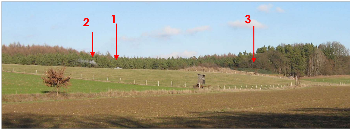
Fotopunkt 4 (Zoom): Bestehende Biogasanlage hinter Geländekuppe, Pfeil 1: Biogasanlage, Spitze Membranfoliendach Fermenter, Pfeil 2: Kondensat Schornstein BHKW, Pfeil 3: Horizontalsilo mit Substrat/ grün abgedeckt
